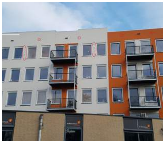
Gierzwaluw- en vleermuiskasten in de gevel van de bibliotheek aan de Waterlandlaan
