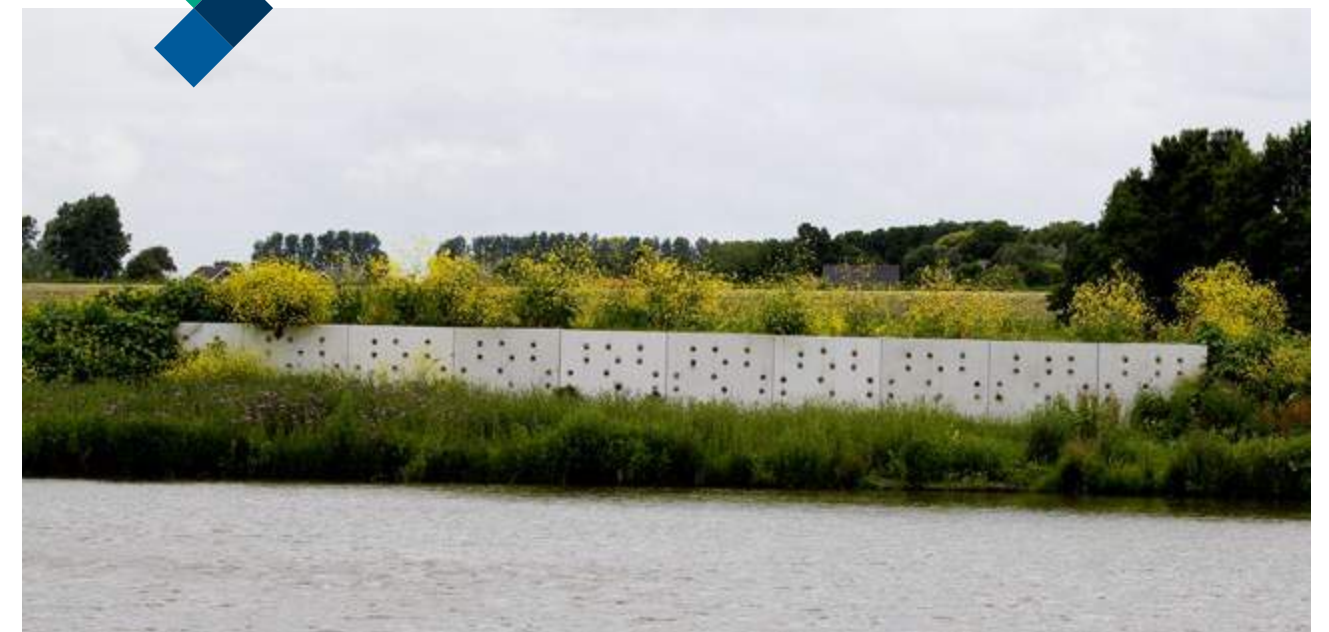
Oeverwaluwbroedwand in Baansteer-Noord
