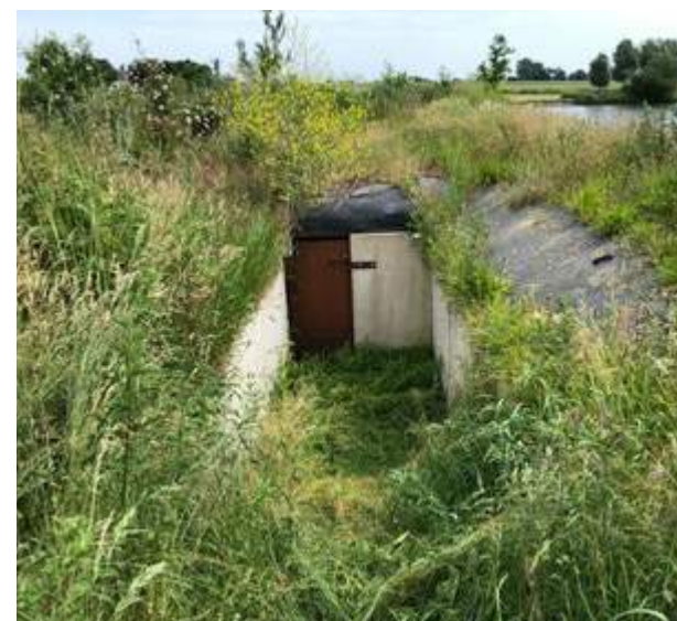
Toegangsdeur vleermuiskelder Baanste Noord
