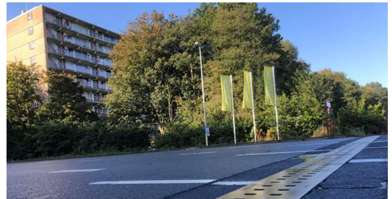
De faunapassage in het wegdek van de Salvador Allendelaan
