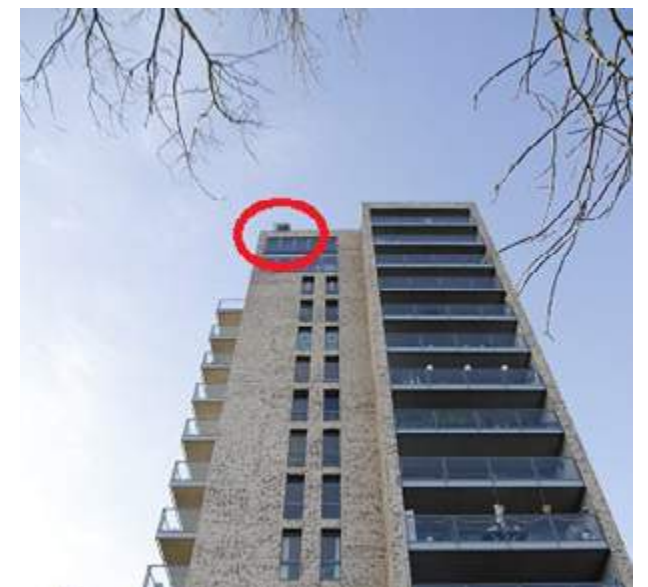
Slechtvalkkast op het dak van de woontoren van Triton
