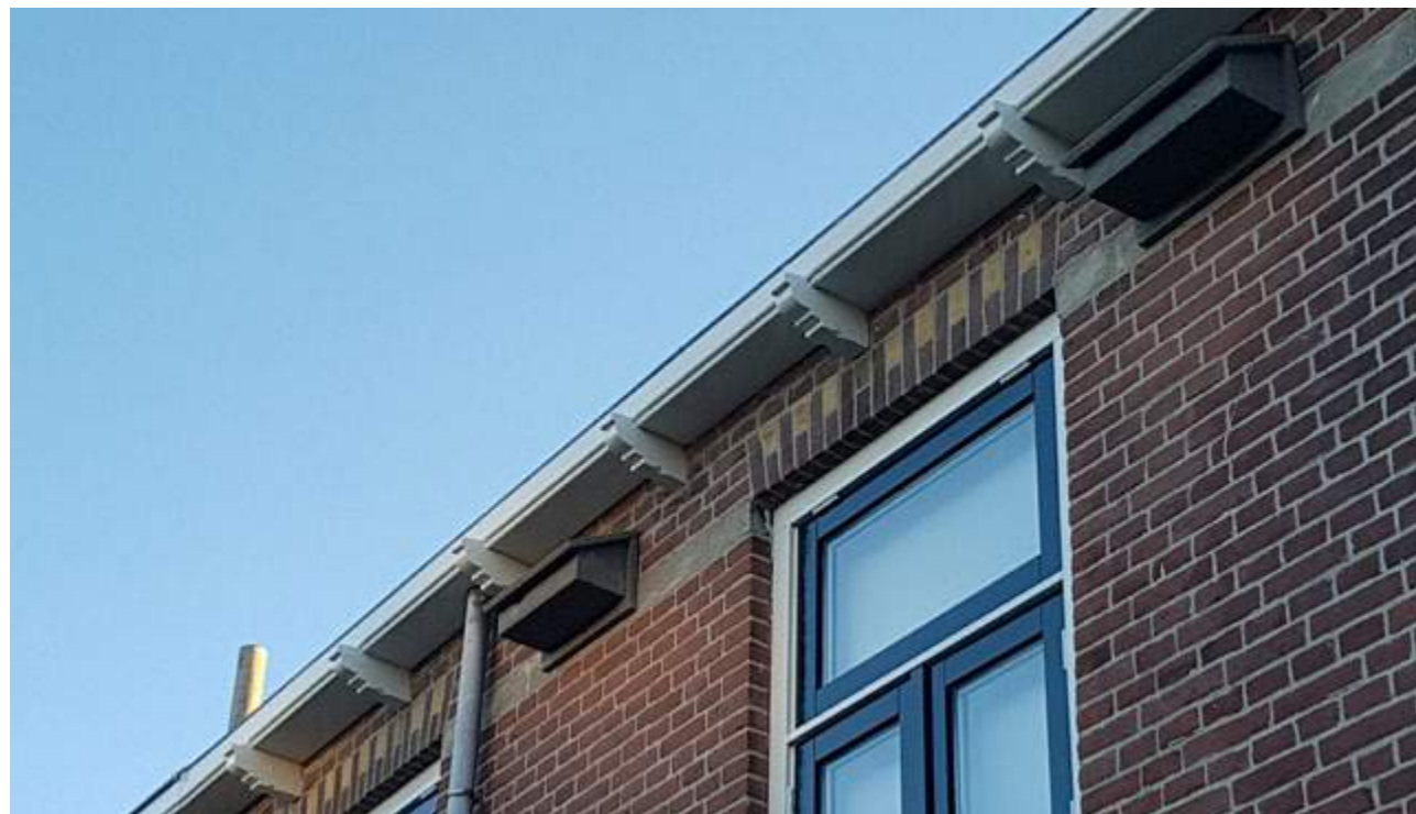
Gierzwaluwkasten op een gevel in de Vooruitstraat
