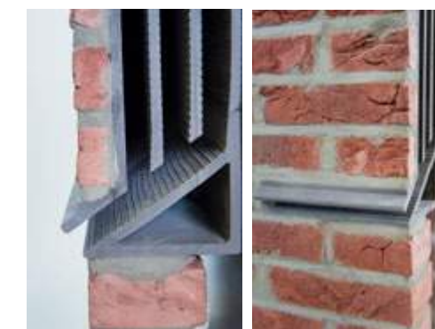
Vleermuiskast doorsnede
