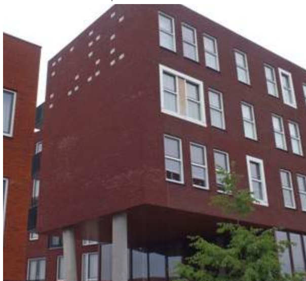
Gierzwaluwkasten in gevel complex Antwerpenhaven spellen FARO 2008 (architect en bouwjaar) in braille
