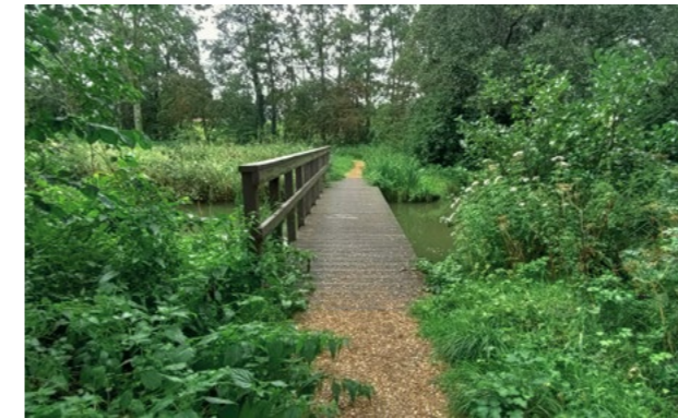
Bestaande en nieuwe vlondersbruggen, materiaal gerecyclede kunststof (type B en H)
