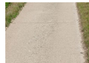
Wandelpaden asfalt met slijtlaag zandkleur
