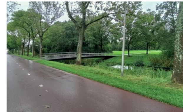
Bestaande fibercore voetgangersbrug (B3)
