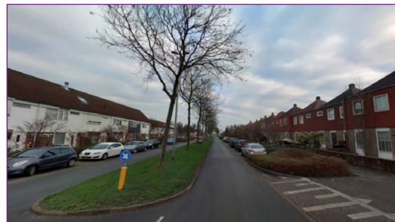
Afbeelding 9: rijbaanscheiding Grotenhuysweg t.h.v. De Graeffweg - Halmstraat
