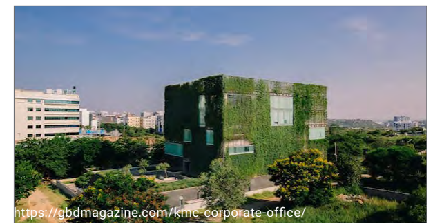
Een nieuw beeldbepalend gebouw op de Schapenmarkt
