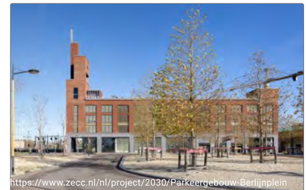
https://www.zecc.nl/nl/project/2030/Parkeergebouw-Berlijnplein Een modern parkeergebouw (Leidscherijn, Utrecht).
