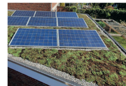
Parkeren onder sedumdak met zonnepanelen
